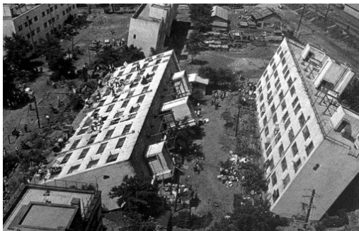
Рис. 12.2. Наклонившиеся здания в Ниигате
