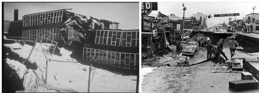
Рис. 12.1. Просадки грунта при землетрясении в Анкоридже
